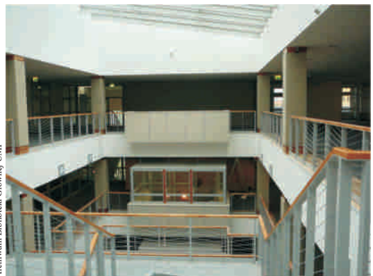
Trwają ostatnie prace wykończeniowe w części bibliotecznego CKD
