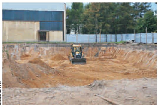
Wykopy pod fundamenty nowego akademika zaczęły powstawać we wrześniu
