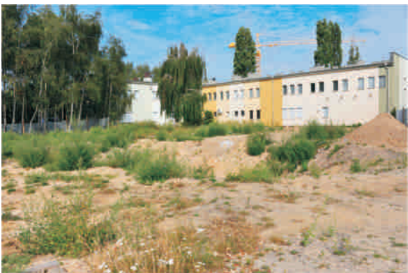
Widok po wyburzeniu budynku SWFiS
