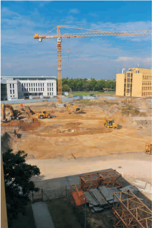
Początek robót przy Centrum Biologii Medycznej w sierpniu 2009
