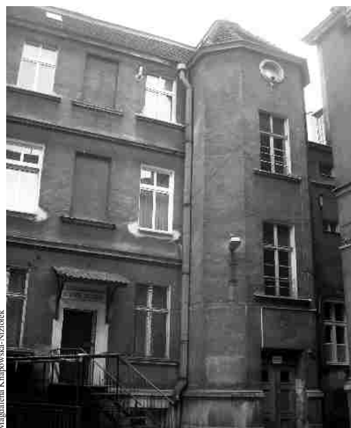
Na miejscu stajni w podwórzu dr Wicherkiewicz zbudował klinikę okulistyczną
